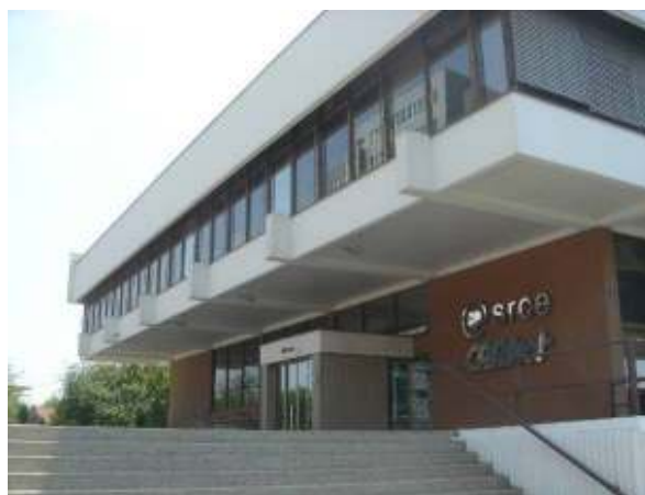
Zgrada Sveučilišnog računskog centra Sveučilišta u Zagrebu Josipa Marohnića 5, 10000 Zagreb
